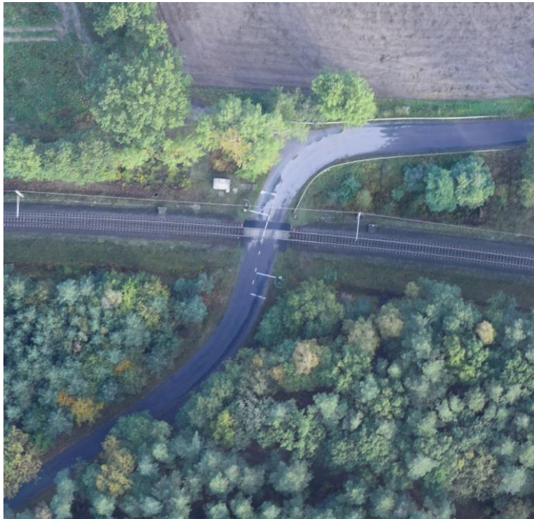
Luftbild Bahnübergang km 84,1 (Kakauer Weg) Quelle: DB Netz AG
