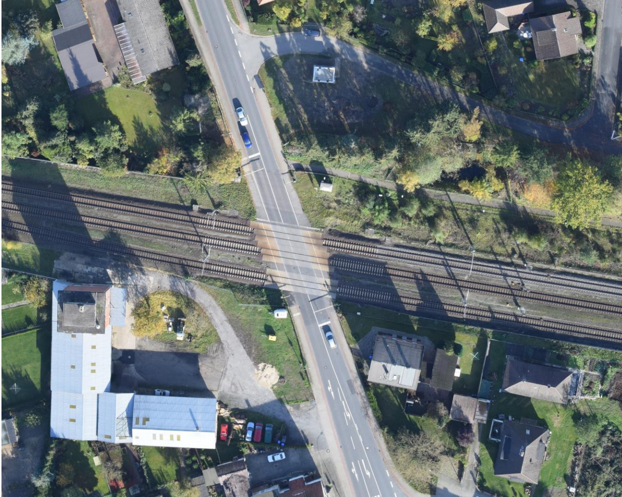
Luftbild BÜ km 93,8 (L270) in Wieren Quelle: DB Netz AG
